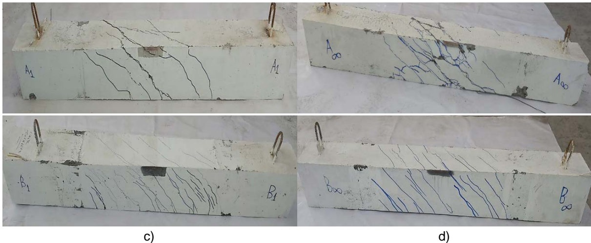
Fig. 20: Crack pattern for the tested beams: a) T/M=0 , b) T/M=0.5 , c) T/M=1 , d) T/M=\infty .
